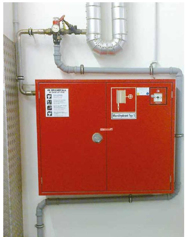
Abb. 9a: Wandhydrant Typ S angeschlossen über Rückflußverhinderer mit Entwässerung
