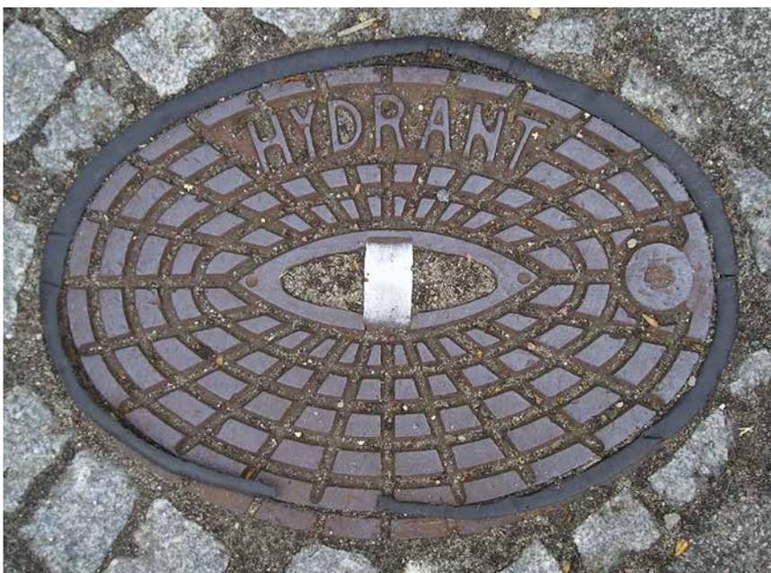
Abb. 2: Straßenkappe eines Unterflurhydranten
