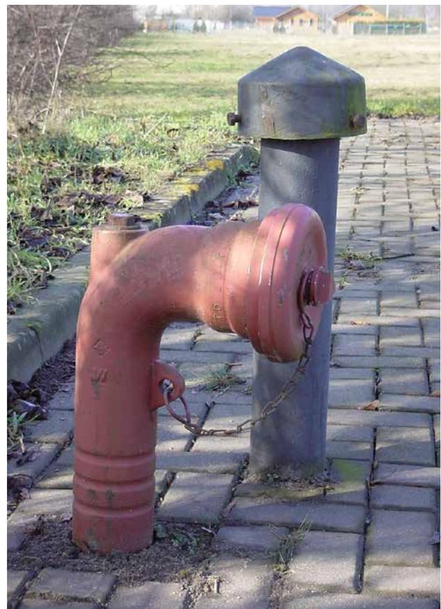
Abb. 8a Löschwasserbehälter ohne Beschilderung
