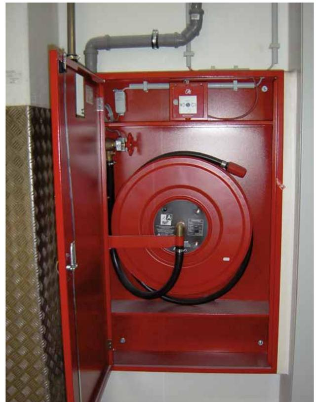
Abb. 9: Wandhydrant Typ S mit formstabilem Schlauch
