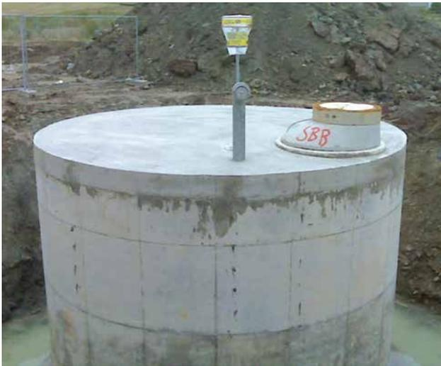
Abb. 8: Löschwasserbehälter K (im Bau)
