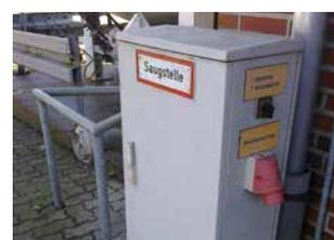
Abb. 4a: Tiefbrunnen (Saugstelle) mit Elektropumpe und Notstromanschluß
