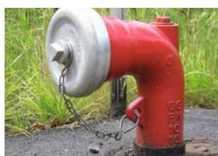
Abb. 6a: Sauganschluss für Löschwasserbrunnen, -behälter oder -teiche
