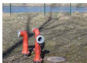
Abb. 6b: Löschwasserteich mit drei frostsicheren Entnahmestellen
