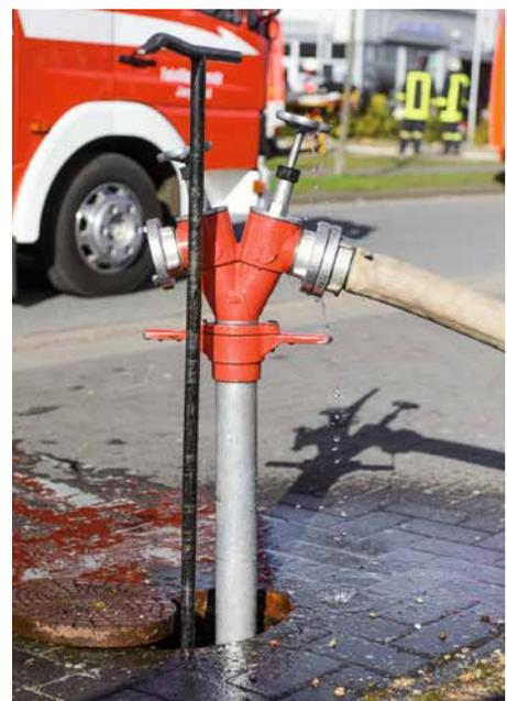
Abb. 2a: Unterflurhydrant mit Standrohr und Hydrantenschlüssel
