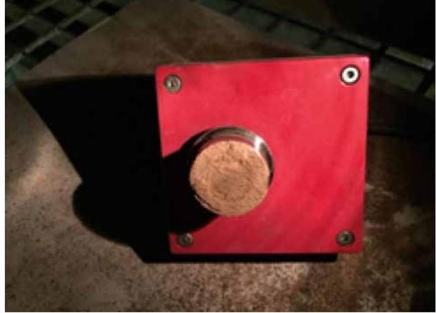
Abb. 10: Funkenmelder mit unzulässigen Holzstaubablagerungen. Hier ist die IR-Sensorik stark beeinträchtigt. Eine Branderkennung ist nicht oder nur stark verzögert möglich.
