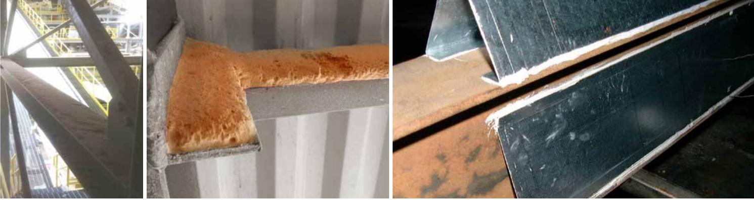
Abb. 3 bis 5: Links: Teile von Fassadenunterkonstruktionen mit übermäßigen Holzstaubablagerungen. Rechts: Konstruktiver Lösungsvorschlag
