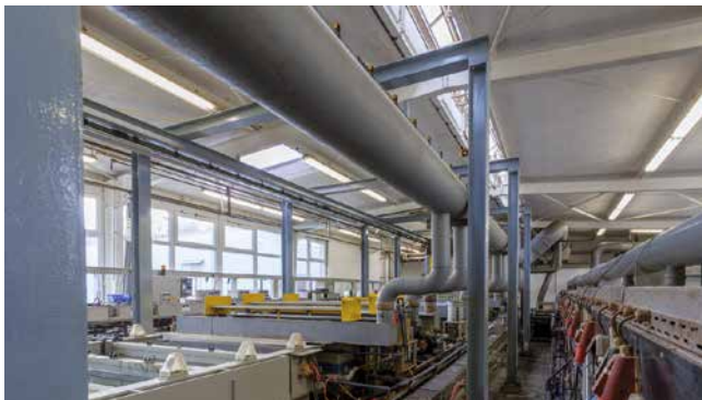
Abb. 6a und b: Brennbare Absaugleitungen sowie Ausstattung und Versorgung der Elektrolytbäder aus Kunststoffen tragen im Brandfall zu einer schnellen Brandausbreitung in der gesamten Nutzungseinheit bei.
