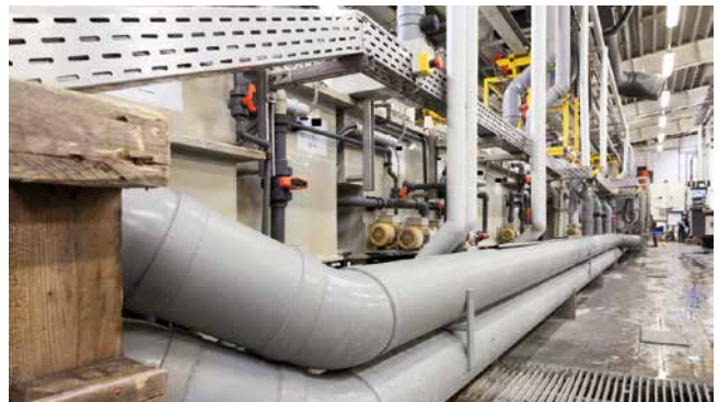
Abb. 6a und b: Brennbare Absaugleitungen sowie Ausstattung und Versorgung der Elektrolytbäder aus Kunststoffen tragen im Brandfall zu einer schnellen Brandausbreitung in der gesamten Nutzungseinheit bei.
